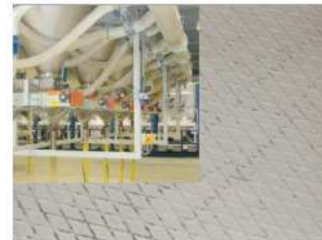
Pavimento di stazione preparazione polveri pulito a secco (in alto a sx. le attrezzature al piano).
